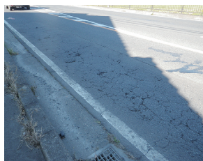
(a) 補修後約5年で破損 (b) 補修後約9年で破損 写真-1 アスファルト舗装の早期劣化区間の例
