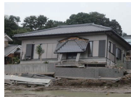
写真2 洗掘による被害を受けた木造住宅
