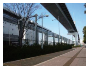
写真2 透明な遮音壁 (透光性遮音板)
