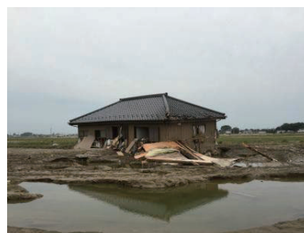
写真1 構造躯体が大破し流出した木造住宅
