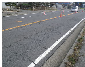
(a) 補修後約5年で破損 (b) 補修後約9年で破損 写真-1 アスファルト舗装の早期劣化区間の例
