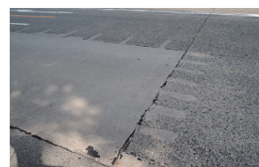
(a) 亀裂・段差 (b) バーステッチ工法 写真-3 コンクリート舗装の損傷例・補修事例
