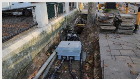
写真2 ロンドンの電力線の埋設事例
