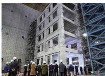
実大5階建て建築物の載荷実験
