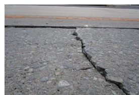
(a) 亀裂・段差 (b) バーステッチ工法 写真-3 コンクリート舗装の損傷例・補修事例
