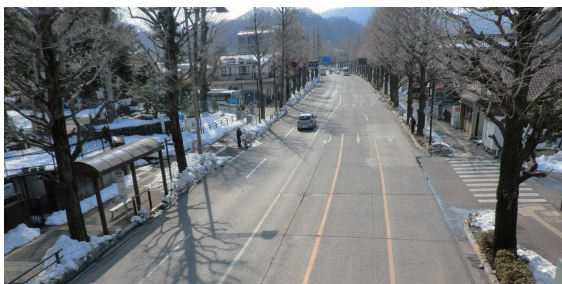
写真1 国道20号東京都八王子市のコンクリート舗装(1957年供用開始、撮影は2014年2月)
