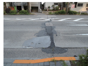
写真2 コンクリート舗装特有の目地部の損傷及びその補修状況
