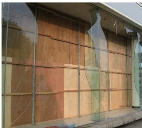
写真1 地震時のガラススクリーンの被害例
