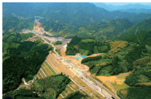
写真-2 規模の大きい盛土
