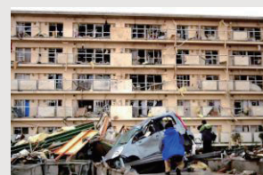
写真-2 集合住宅の被害
