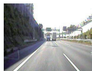
図2 遮音壁ありの区間
