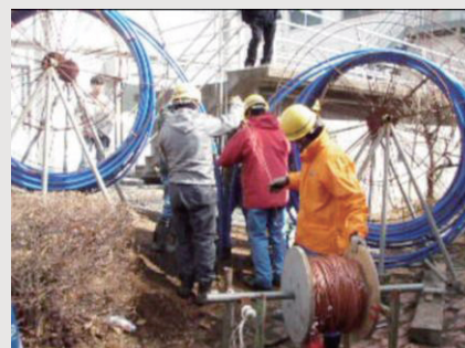
写真 地中埋設管の設置作業状況
