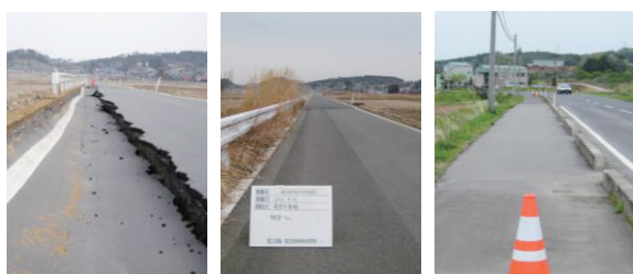
未対策 砕石による埋戻し 埋戻し土の固化 写真 耐震対策効果の確認
