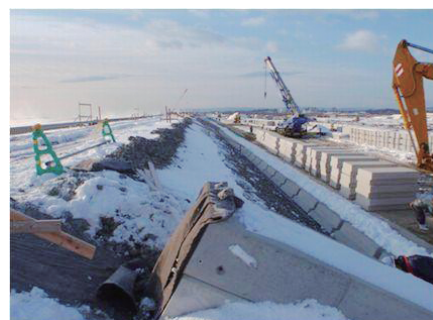
写真 切り欠きブロック敷設状況
