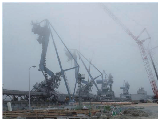
図-1 相馬港アンローダーの倒壊
