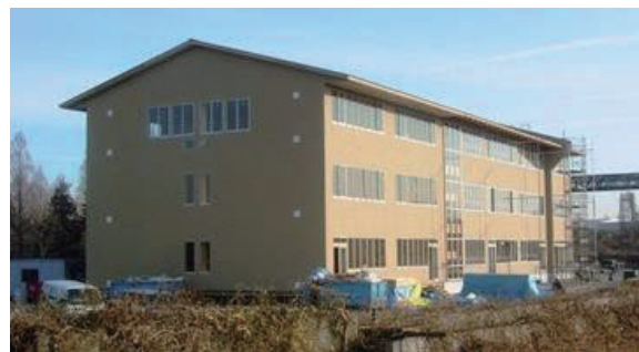
写真1 木造3階建て学校実験建物
