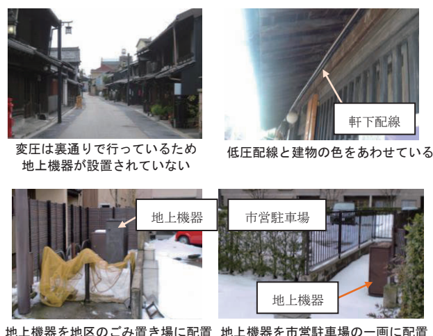
写真1 軒下配線、地上機器配置の工夫事例
