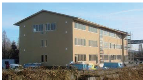
写真1 木造3階建て学校実験建物
