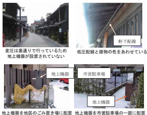
写真1 軒下配線、地上機器配置の工夫事例
