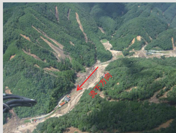
写真 篠堂川における崩壊、土石流の発生状況
