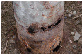
写真-1 舗装で覆われた 支柱基部の腐食
