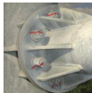
写真-1 舗装で覆われた 支柱基部の腐食
