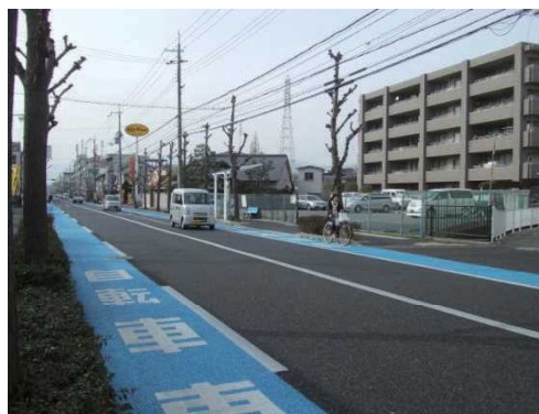
図2 整備事例（兵庫県尼崎市）
