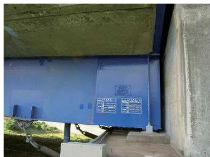
写真-2 実橋での試験施工
