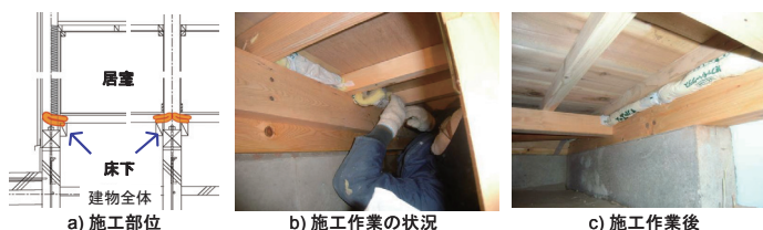
図 施工性検証実験の状況(床下気流止め施工)
