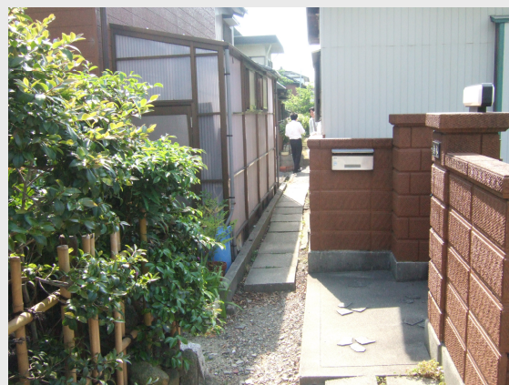
写真-1 下水道工事の困難な狭小路地
