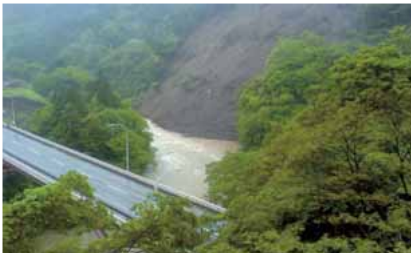
河道が閉塞した事例（岐阜県揖斐川、平成18年5月13日撮影）
