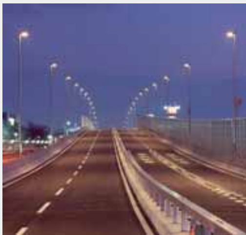
直線ポールを用いた道路照明
