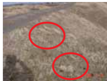
図－2 堤防のモグラ穴（2006年3月）
