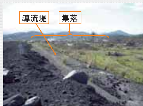
写真－2 効果を発揮した導流堤
