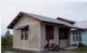
写真1：補強煉瓦造復興住宅
