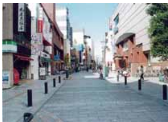
写真－1 道路整備後の状況
