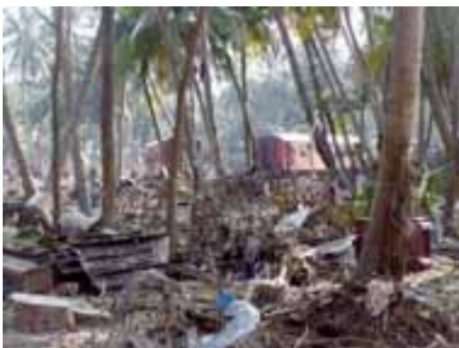
写真－1 スリランカにおけるインド洋大津波の被害（五洋建設㈱提供）
