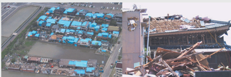
写真－1 建築物の被害状況
