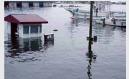
津波で浸水した十勝港（広尾海上保安署提供）
