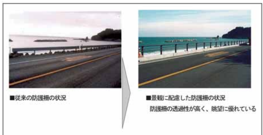
図 - 1 景観に配慮した防護柵の設置例
