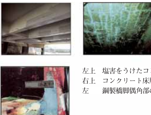
写真-1 道路橋の損傷例
