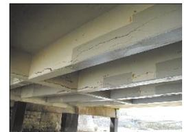
写真 - 2 コンクリート部材の塩害被害
