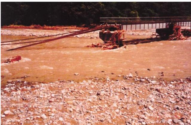
写真 - 2 姫川での橋梁の被災
