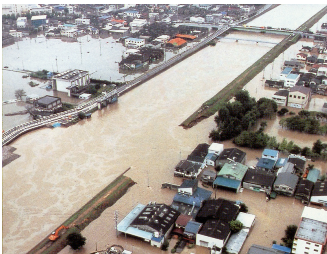
写真-1 新川における破堤の状況(左岸16k地点) 約100mにわたって破堤した
