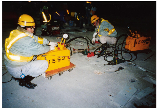
写真－4 緊張力の導入状況
