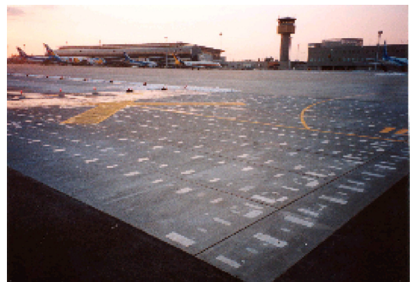
写真－5 完成したPPC版舗装
