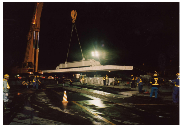
写真－3 PPC版の敷設状況
