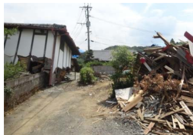
写真2 住宅地の被災状況 御船町
