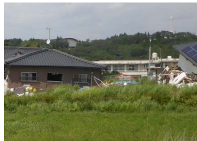
写真1 住宅地の被災状況 南阿蘇村
