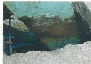
鋼トラス部材の埋め込み部の破断
