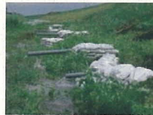
河川堤防の漏水
