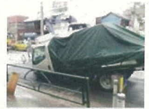
埋設管破損による道路陥没
