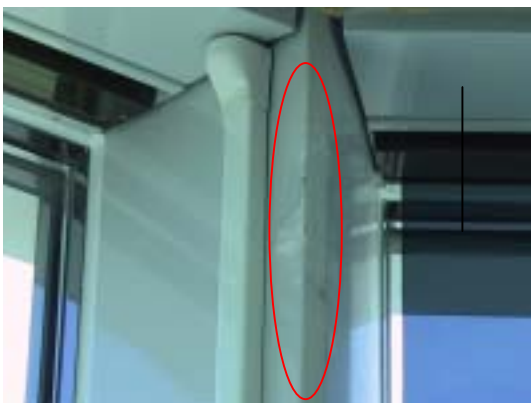
管制塔の柱の仕上げに傷あり
