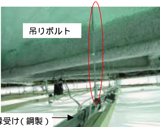
管制塔の天井
