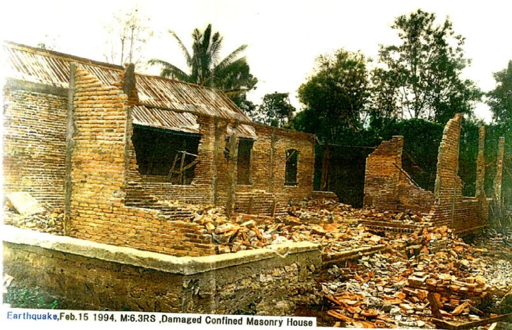
組積造住宅の被害例（インドネシア・スマトラ島リワ地震：1995年2月）
