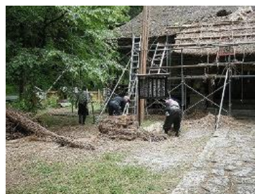
定期的な修復作業
