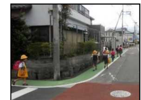
路肩のカラー舗装
