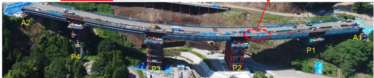
大切畑大橋の復旧(残留変形が生じた主桁をあえて残置したうえで新たに縦桁や対傾構を追加設置)
