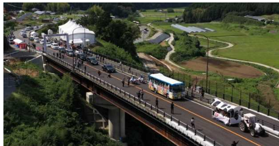
復旧が完了した大切畑大橋 (令和元年9月14日)
