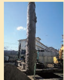
既存杭の撤去工事の状況
