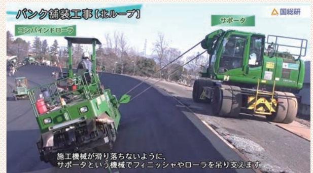
バンク舗装工事
