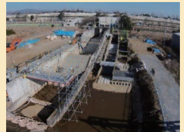
「粘り強い河川堤防」整備の検討に必要な越水実験等が可能な実験水路を整備
