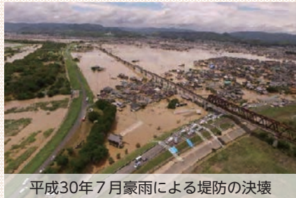
平成30年7月豪雨による堤防の決壊
