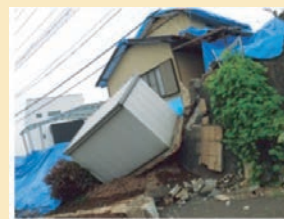
被災した宅地と住宅
