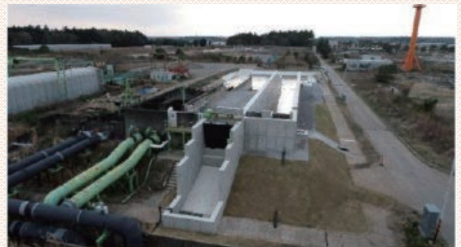
大規模堤防模型実験水路
