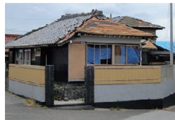
台風による瓦屋根の被害例 (令和元年台風第15号)
