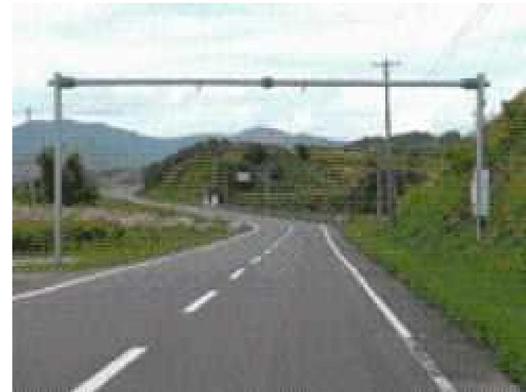
簡易型交通量計測装置
