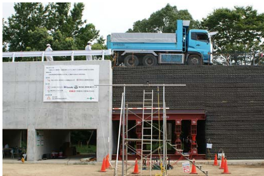
道路基礎構造実験施設に構築された実験盛土
