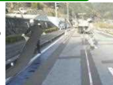
クラック防止シート張り作業
