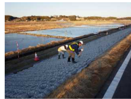
アンカーピン打設状況
