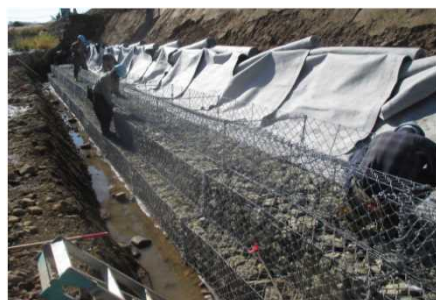
かご組立・据付状況
