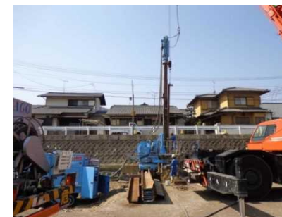
鋼矢板圧入状況
