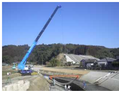
ブロックマット据付状況
