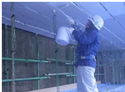
仕上げ塗装状況
