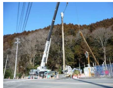
鋼矢板吊り込み状況
