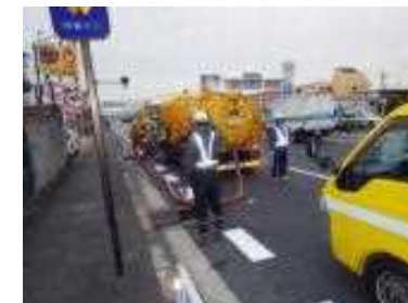
管渠清掃作業
