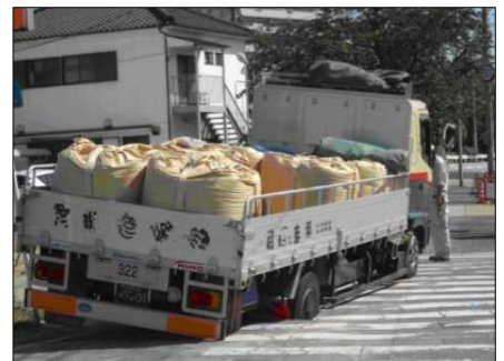
管路の老朽化に起因する道路陥没
