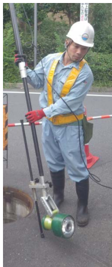
管口カメラ(スクリーニング調査)
