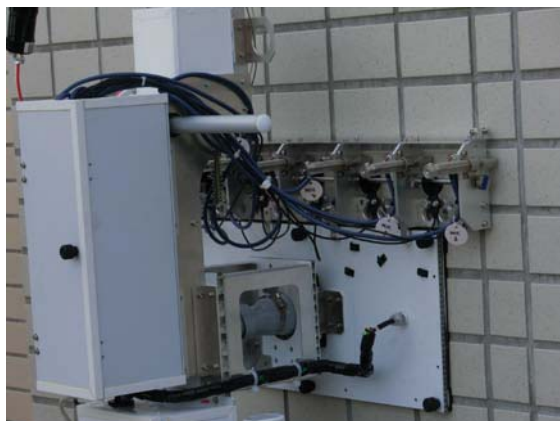
写真3 打音装置の取り付け状況
