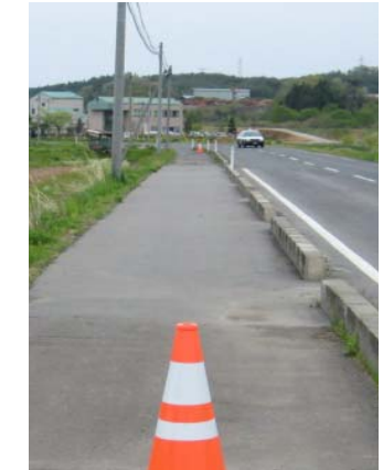
対策箇所(被害なし)
