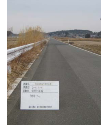
対策箇所(被害なし)
