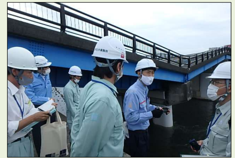
令和3年7月1日からの大雨 被害の様子の調査 (静岡県沼津市 黄瀬川大橋)
