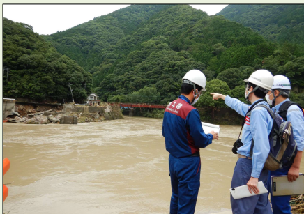
令和2年7月豪雨(ごう) 被害の様子の調査 (熊本県 球磨川 道路橋)
