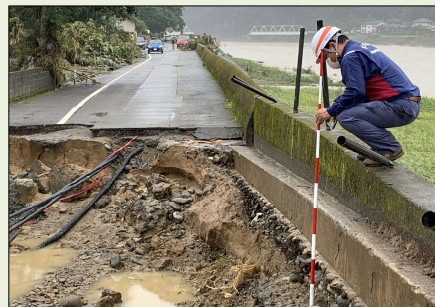
令和2年7月豪雨(ごう) 被害の様子の調査 (熊本県 球磨川 堤防欠損箇所)
