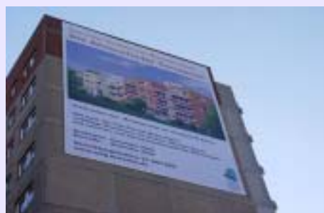
高層住棟を中層住棟に減築(ドイツ)
