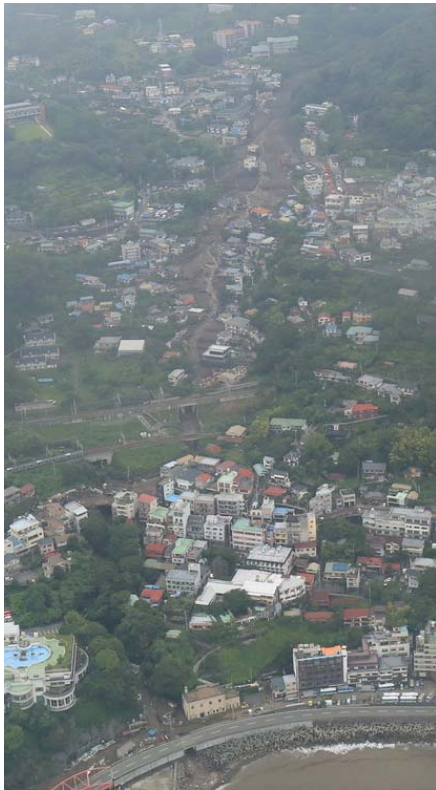
被災状況 (7月5日 国土地理院撮影)
