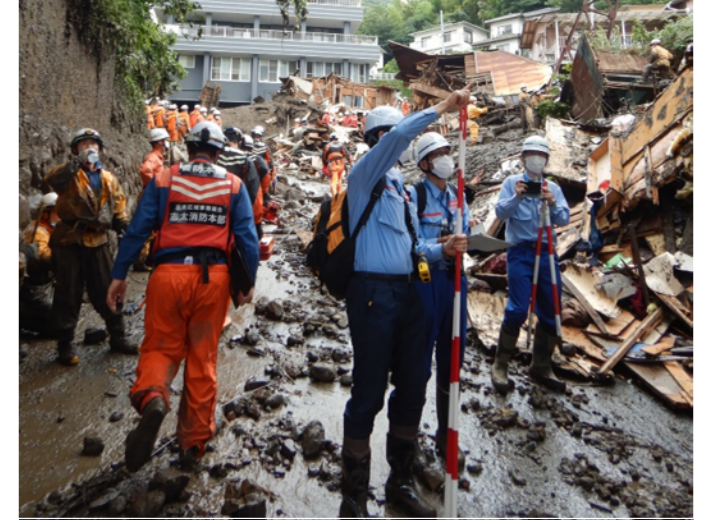
被害状況の調査 (7月5日)
