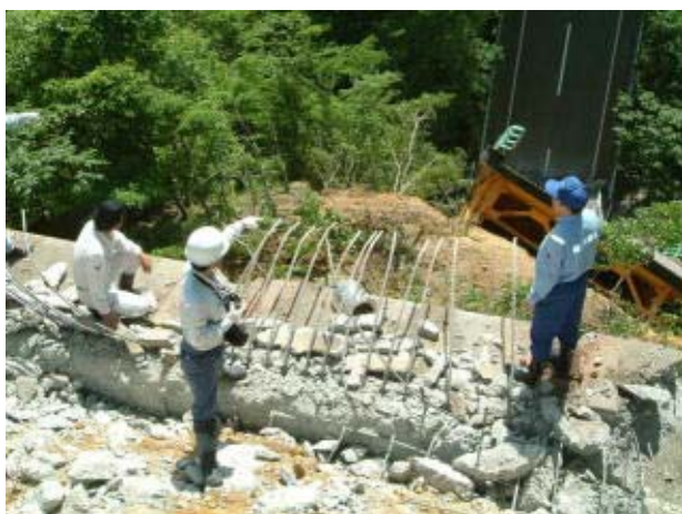
A2 橋台から見た落橋の状況
