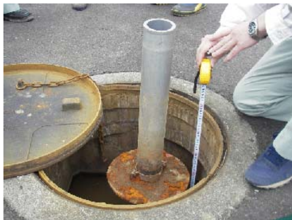
挿入パイプの突き出し
