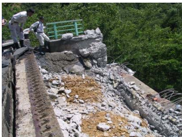
A2 橋台のパラペットと躯体部の離れ
