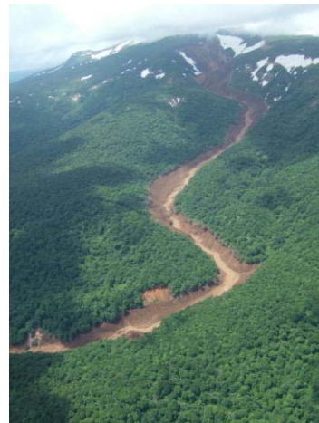
三迫川土石流流下区間
