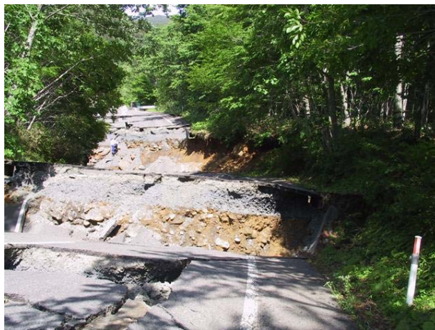
A1 橋台後方部の地割れ(奥が祭時大橋)
