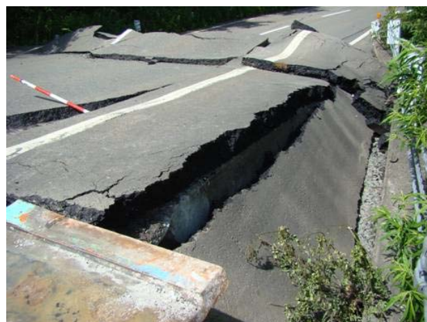
A2 橋台背面の状況
