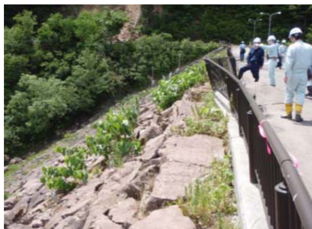
下流側法面 被災状況
