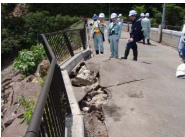
天端 被災状況
