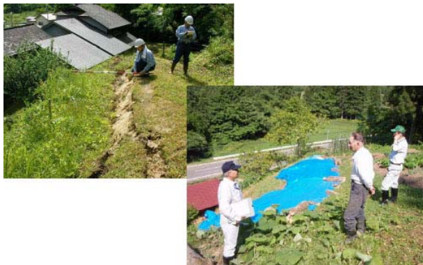
緊急点検と応急対策状況
