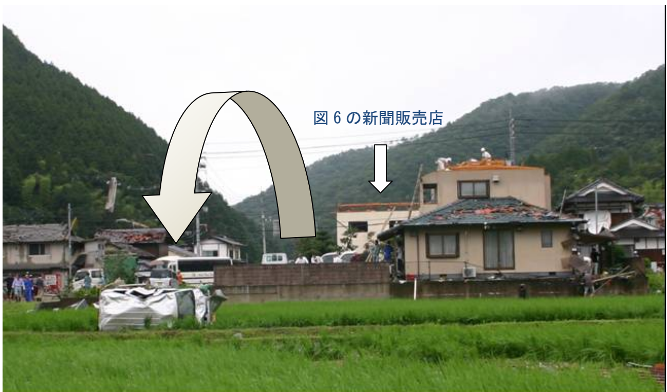
図 14 屋根が飛ばされた住家（平成 8 年築）と水田に飛ばされた軽自動車（美作市撮影）
