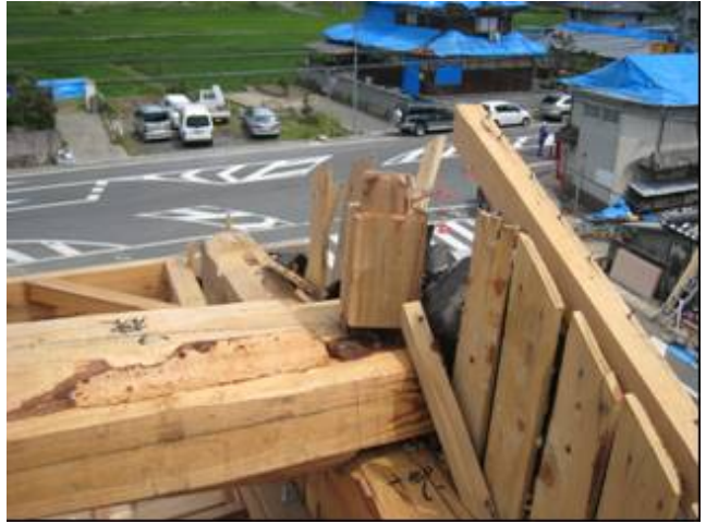
図8 地棟の南側端部
