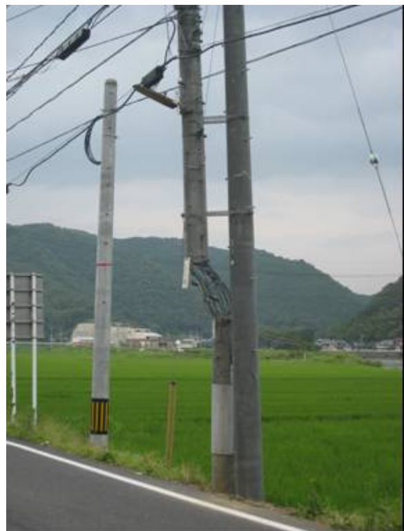
図 27 折損した電柱の補強 (右側の柱)
